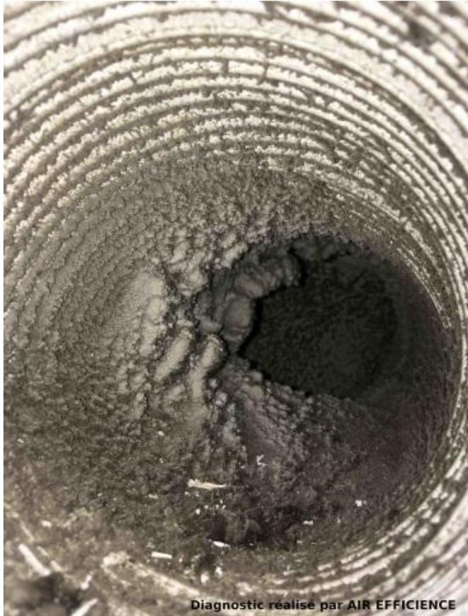
L'entretien du conduit d'extraction n'a jamais été réalisé. L'encrassement du conduit est très important ce qui engendre une augmentation des pertes de charges sur le réseau. Le débit extrait par la bouche d'extraction est donc réduit de façon significative.
