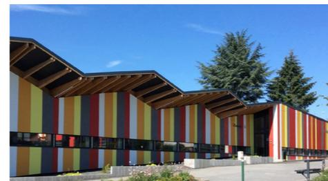
tion ; un procédé bois/paille en caissons par l'extérieur pour les murs et la couverture, et 30 cm à 40 cm de ouate de cellulose soufflées pour les combles et pléniums existants.
